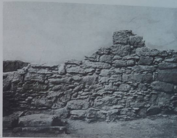
Рис. 4. Северная стена мавзолея. Вид с юга
